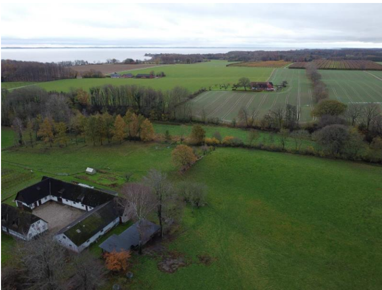
Figur 2: Vrangbækken løber rørlagt gennem engen ved Vrangbækgaard. Vrangbækken løber til Lillebækken mellem træerne til venstre i billedet.
