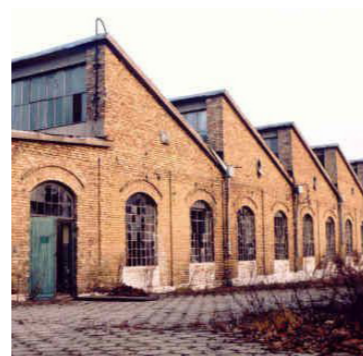
Shedtage på ældre industribygning.
